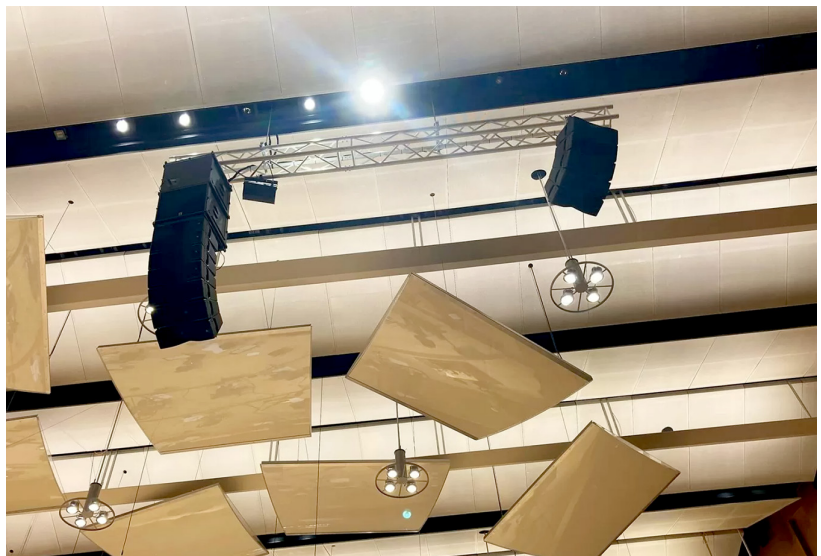
大ホールの最終的なシステムは、カーディオイド構成で配置された7台のKiva IIと2台のSB15mサブウーハーの左右のハングで構成されています。
