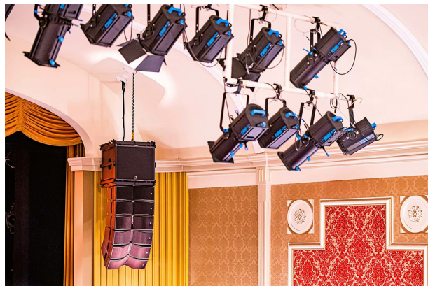
シャウブルク・オフテロップ劇場のL-Acoustics Kiva II メインシステム
