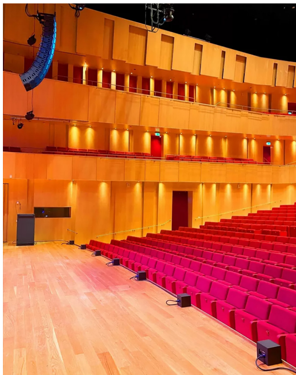
中央に 4 台の SB18 と片側に 14 台の Kara II のフライング・メインシステムに加え、左右に 2 台ずつグラウンドスタックされた計 4 台の KS28 による Spira のメインシステム。フロントフィルは 5XT、バルコニーフィルには X8 を使用。
