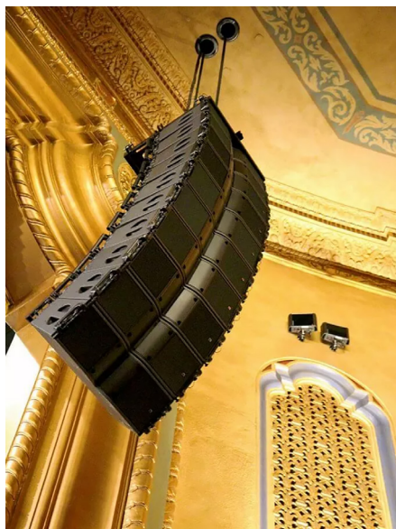
会場の2つのメインアレイは10台のL-Acoustics Kara II エンクロージャーで構成されています。(撮影者: Katy Denight)
