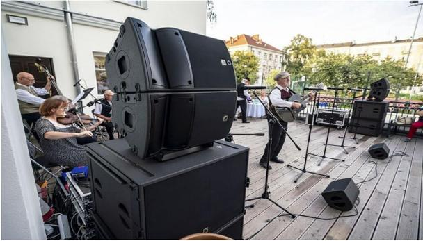
屋外にあるガーデンテラスの大きなステージには、Audio Plusが4台のA10WideとSB18mサブウーハーによるA-Seriesシステムを納入し、コンサートや夏のオープンエアシネマで使用されています。システム全体は4台のLA4Xアンプリファイド・コントローラーでドライブされ、移動用と常設用の2つのグループに分けられています。
