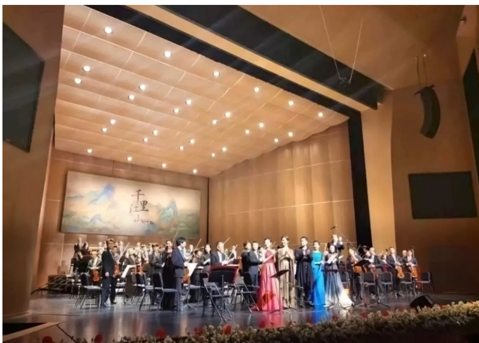
L-Acoustics Kara II を10台使用した LCR メインシステムは、エレガントな外観のホールに最適なサウンドカバレッジを確保し、SB18 サブウーハーがローエンドを供給しています。
