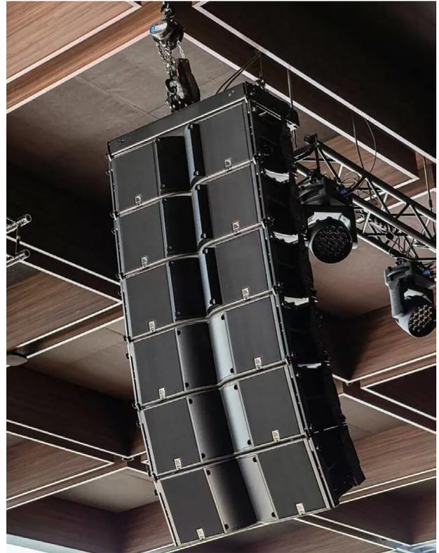
エミリー・イベントホールの音響システムは、L-Acoustics K3の左右アレイとKS28サブウーハーで構成されています。
