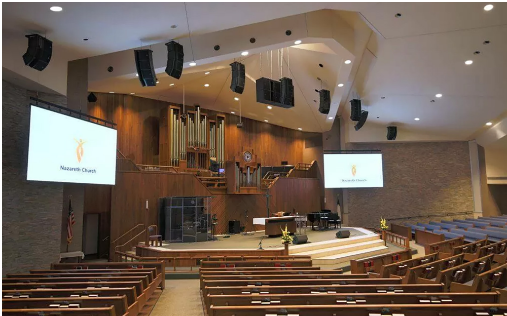
教会の新しいスピーカーシステムは、34台のA10iエンクロージャーによる9つのアレイと、6台のKS21iサブウーハーによるセンターハングで構成されています。
