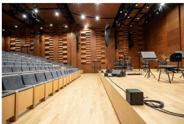
L-Acoustics Xシリーズはフロントフィルシステム、ステージモニタリングシステムを担当。
