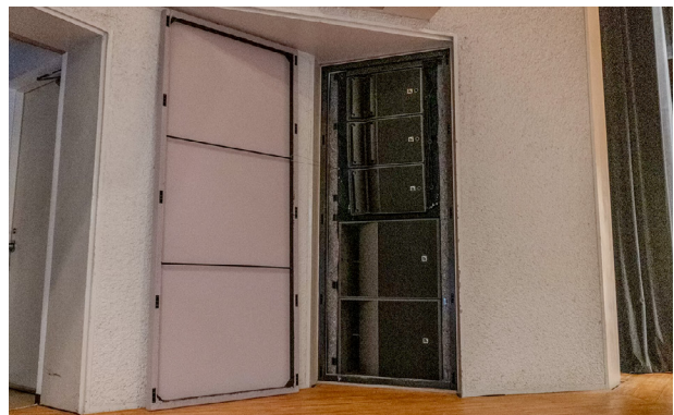
サランネットを外したサイドスピーカー室： A10i Focus × 2、A10i Wide × 1、KS21i × 2
