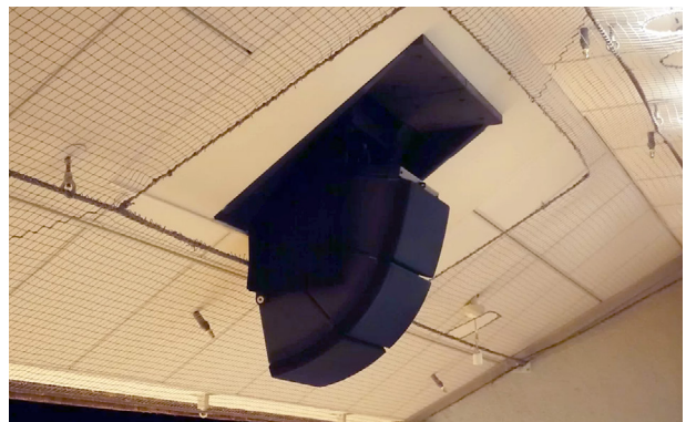
プロセニアム（センター）： A10i Focus × 3 に音響透過スクリーン A10i FOCUS-SCREEN を装着
