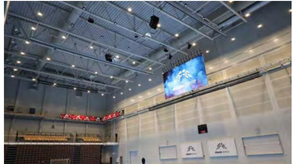
ハンドボール競技場には、目立たないデザインと広い帯域幅を持つL-Acoustics A15が選ばれました。2台のA15Focusと1台のA15Wideによる合計4つのアレイが2つの観客席に音を届けています。A15の15インチドライバーは広い周波数特性を確保し、スピーチと音楽の両方で観客に素晴らしい音響体験を提供します。その広い帯域幅が、サブウーハーの追加を必要としないことを意味します。4台のX12コアキシャル・キャビネットがフィールドをカバーし、システム全体はLA4Xアンプリファイド・コントローラーでドライブされています。
