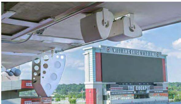
A15iは低域を40Hzまで拡張するため、設計上サブウーハーが不要になったことを指摘します。「さらに低域を最適化するために、フルレンジのAutoFilterを適用します。」と続けます。「これは、Network ManagerとSoundvisionモデルのシームレスな統合によって可能になりました。フィルタの設定は自動的にアンプリファイド・コントローラーにインポートされるので、大きな労力と時間の節約につながりました。完全なエコシステムのアプローチにより、設計も展開も簡単かつ迅速になりました。」
