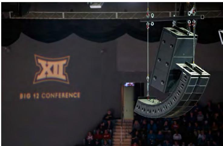
DSSの設計者とインテグレータは、L-Acousticsのエンジニアと協力し、Soundvision 3Dのアカースティック・モデリングソフトウェアを使用して、アリーナに新しいPAシステムを設計しました。この新しいシステムは、8つのKaraiアレイで構成されています。11台のKaraiスピーカーによる4つのハングがコートの長辺を、さらに9台のKaraiによる4つのハングがコートの端をカバーしています。各アレイは、DSSによって製造されたカスタムバンパーに取り付けられた、3台のSB18iサブウーファーによって補強されています。これにより、スピーカーとサブウーファーが完全にタイムアラインされて、スピーチの明瞭度を確保することができます。さらに、4台のKiva IIによる4つのハングがそれぞれ中央に取り付けられたスコアボードの下部に固定されており、コートの端を囲む客席を均等にカバーしています。システム全体は、28台のLA4Xアンプリファイド・コントローラーによってドライブされています。
