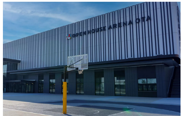
オープンハウスアリーナ太田（太田市総合体育館）
