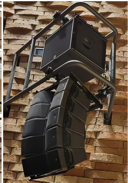
反射板の間に設置された Kivall, SB15m、インフィルスピーカー X8(左)、 小ホール サイドスピーカー Kivall, SB15m(右)
