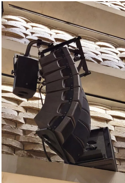
反射板の間に設置された Kivall, SB15m、インフィルスピーカー X8(左)、 小ホール サイドスピーカー Kivall, SB15m(右)
