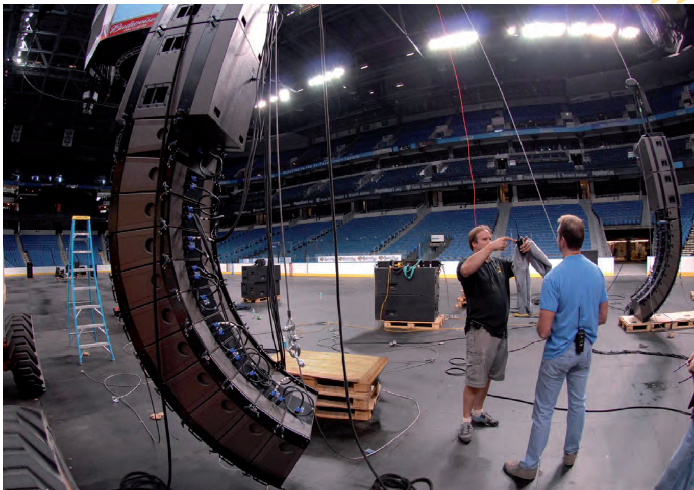
タンパベイ・ライトニングが拠点とする、タンパベイ・タイムス・フォーラムにdV-DOSCシステムの設置を行いました。会場の過密なスケジュールに合わせ、L-ACOUSTICSサウンド・システムの構築（リギング、ワイヤリング、アンブラック、アレイのフライング）を3日間で完了させました。
