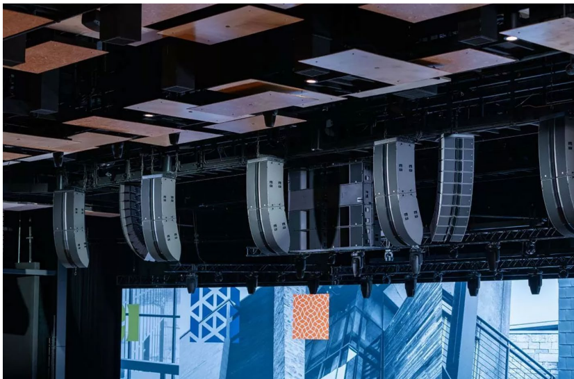
10台の Kara II によるアウトフィルと、Lシリーズのシーンアレイ
