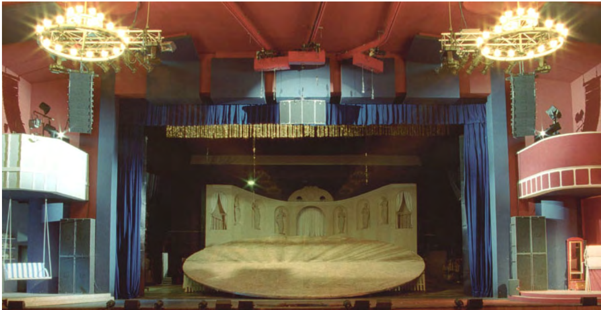
図 34 : フライングした ARCS センタークラスター（FOH L/R は dV-DOSC）
