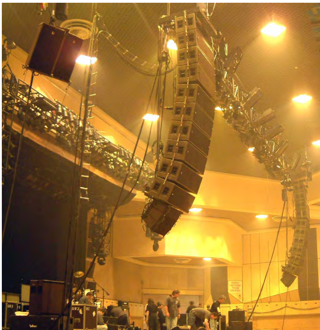
図 38：ARCS のオフステージフィル+サイドフィルの例
