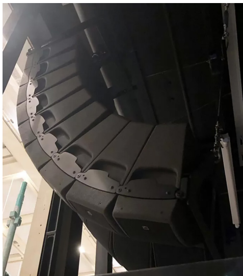
1Fと2F席をカバーする9台のKiva II 写真提供：広島国際会議場
