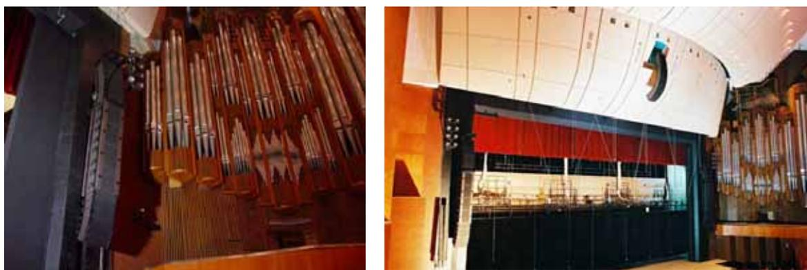
図 66: dV-DOSC と dV-SUB をハイブリッド型にしてセンタークラスターを加えた例
