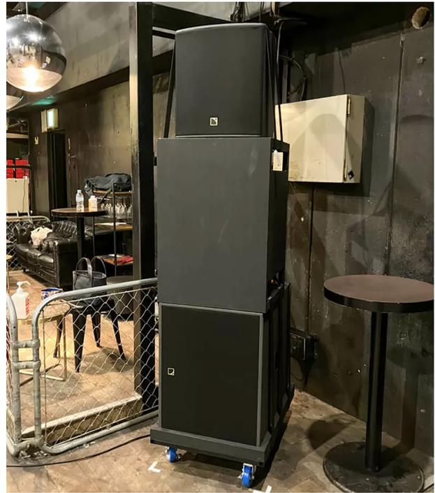
リアスピーカー。SB18との間にスペースを作ることによってX12の高さを確保している
