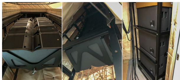
サイドスピーカー: Karall の Panflex により会場の特性に合わせて調整、上下で違うセッティングになっている (左)。裏側 (中)。サブウーハー KS21 (右)
