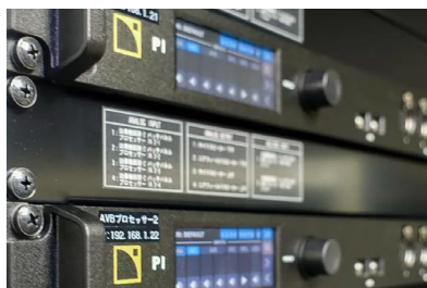
P1はアンブ室に置かれたLA4XとLA2Xiの制御と管理を担う
