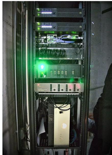
プロセニアムスピーカー用パワーアンプ「LA4X」が収納されたラック架。プロセニアムアーチ下手奥に設置されております。
