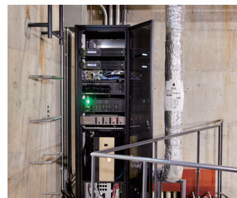
▲ステージ上・下手奥の天井裏に設置された、プロセニアム・スピーカー用のパワーアンプLA4X。
