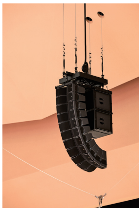
▲新たに作り変えられた天井から、しっかりと吊るされたプロセニアム・スピーカー。こちらの使用で、死角なくホール全体に音を届けることが可能
