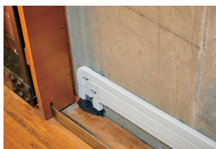
▲ステージ・フロントのスピーカー・X4i(写真左)。こちらの配線は、ステージ・サイドの下手から引かれている(写真右)
