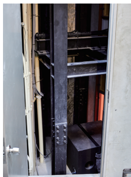
▲サイド・コラム・スピーカー(写真左)。ももとのスピーカーはこの背面の奥まった場所に設置されていたが、その場所に鉄骨を組んで現在のスピーカーを支えている(写真右)
