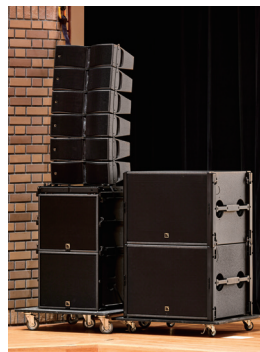
▲移動型スピーカー(写真左)。すべて台車に乗せて可搬性を確保しつつ、しっかりとホールドできるように壁にはスピーカー留めの金具が付けられている(写真右)
