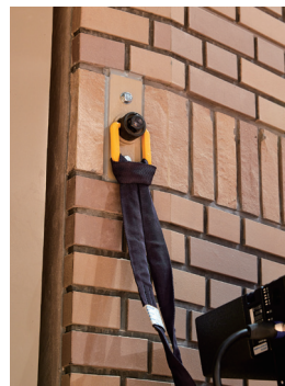
▲移動型スピーカー(写真左)。すべて台車に乗せて可搬性を確保しつつ、しっかりとホールドできるように壁にはスピーカー留めの金具が付けられている(写真右)
