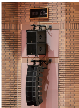
▲サイド・コラム・スピーカー(写真左)。ももとのスピーカーはこの背面の奥まった場所に設置されていたが、その場所に鉄骨を組んで現在のスピーカーを支えている(写真右)
