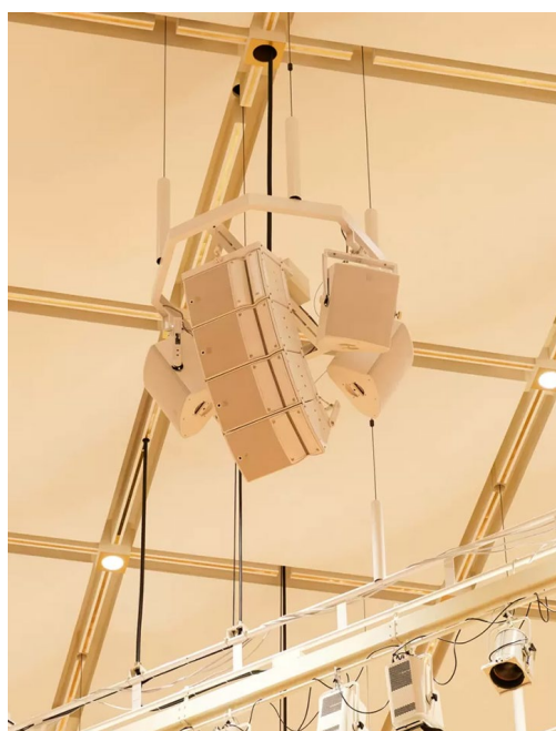
センタークラスター。ステージ付近まで下ろして撮影。 センターは上から A10i Focus × 3、A10i Wide × 1。 X12 はバルコニーのために横と後方に向けられている。
