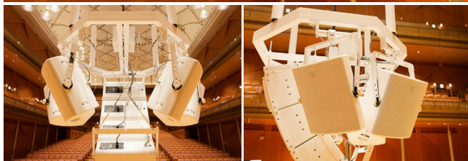
センタークラスター。ステージ付近まで下ろして撮影。 センターは上から A10i Focus × 3、A10i Wide × 1。 X12 はバルコニーのために横と後方に向けられている。
